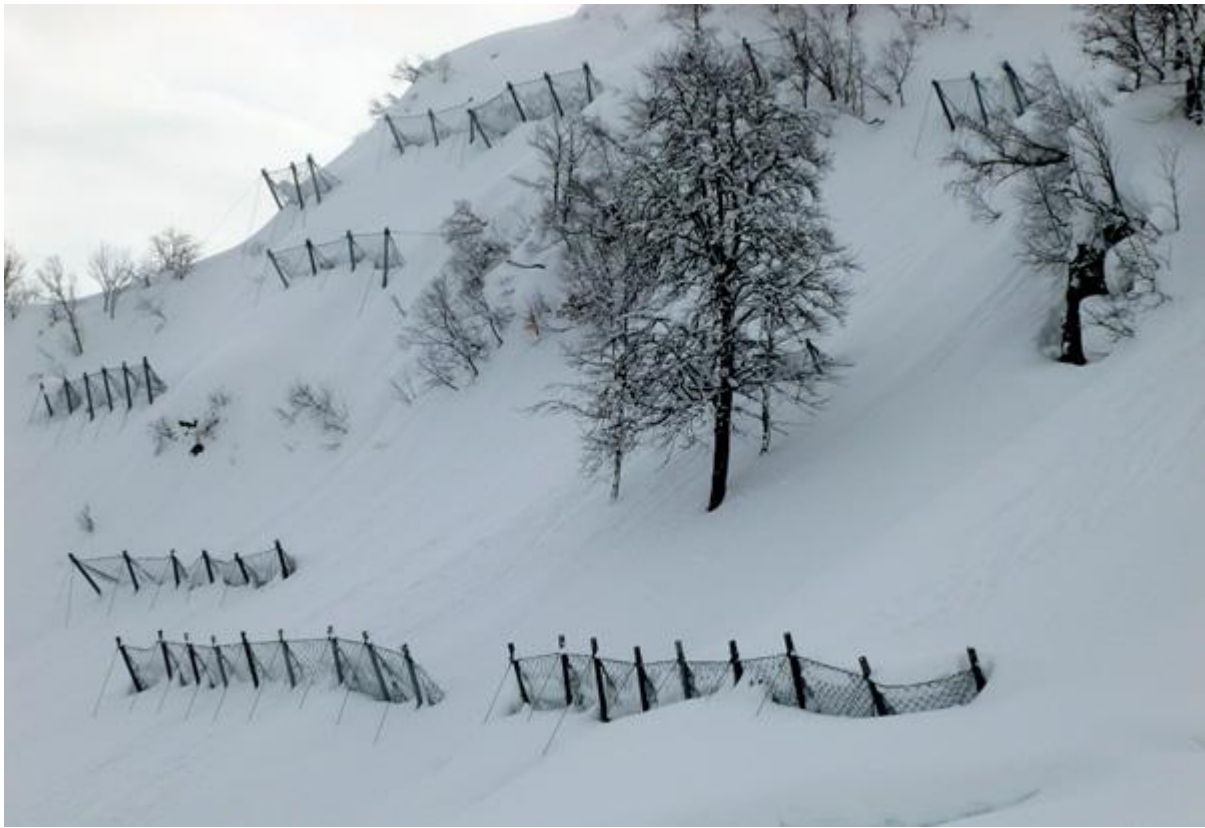
სურ. 3.2.4 ზვავის შემაკავებელი ალუმინის ბადე
