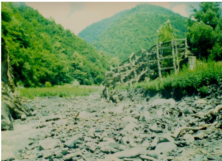
სურ. 2.3. მდინარე დურუჯის კალაპოტში მწვობრიდან გამოსული გამჭოლი ტიპის ღვარცოფსაწინააღმდეგო ნაგებობა (2000 წ.)
