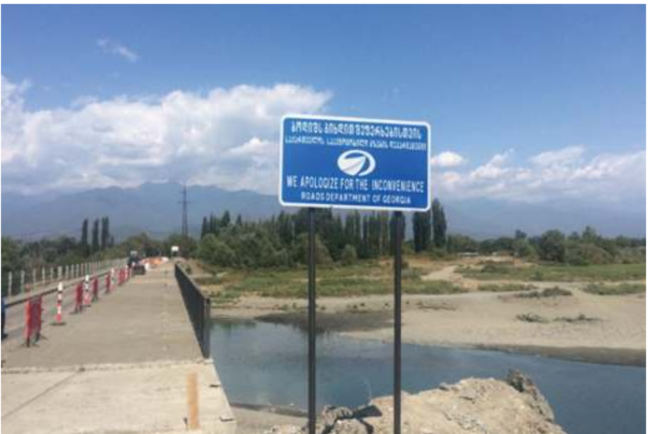
დასახლებულ რეგიონში ხიდზე მიმდინარე გზის სამუშაოები
